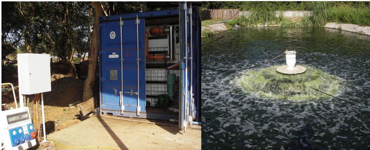
Figure 15. BioKube et aérateur aux lagunes pour le traitement des eaux usées (Cité 1)
