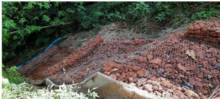
Figure2: Stabilisation d'un lieu de drainage d'eau à la source de Gouan
