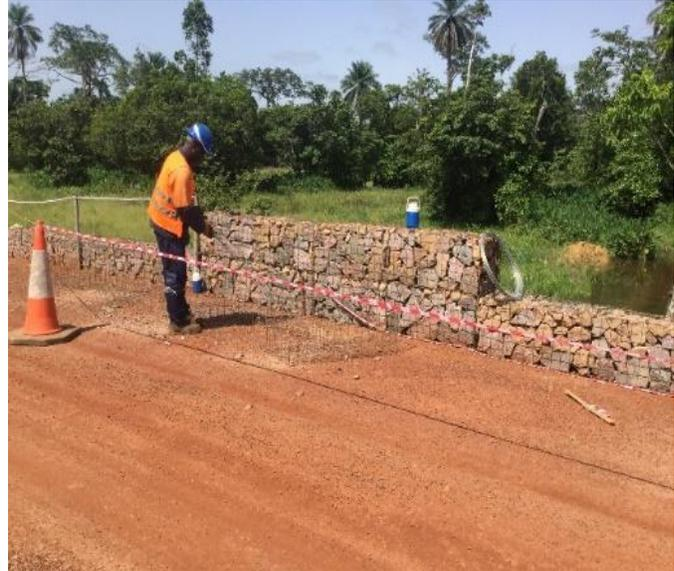
Figure 11 : Construction des gabions
