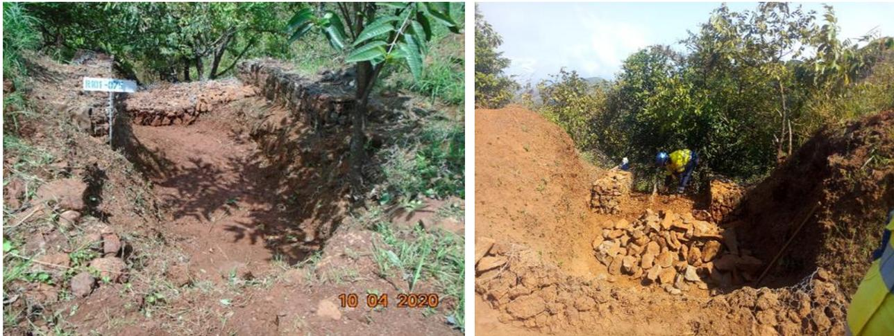
Figure 12: La désédimentation et la maintenance des structures
