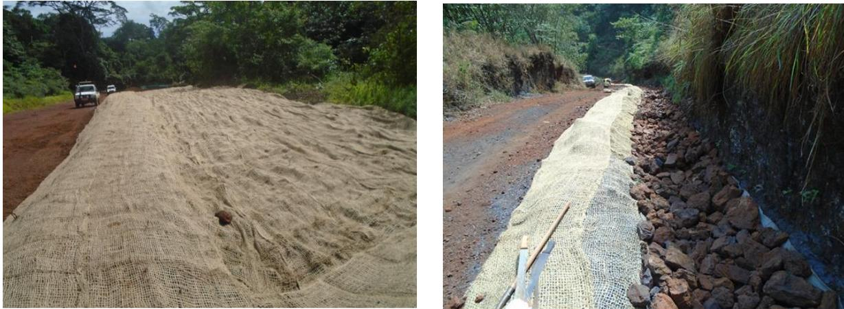
Figure 14 : La pose des jutes net pour la stabilisation du sol
