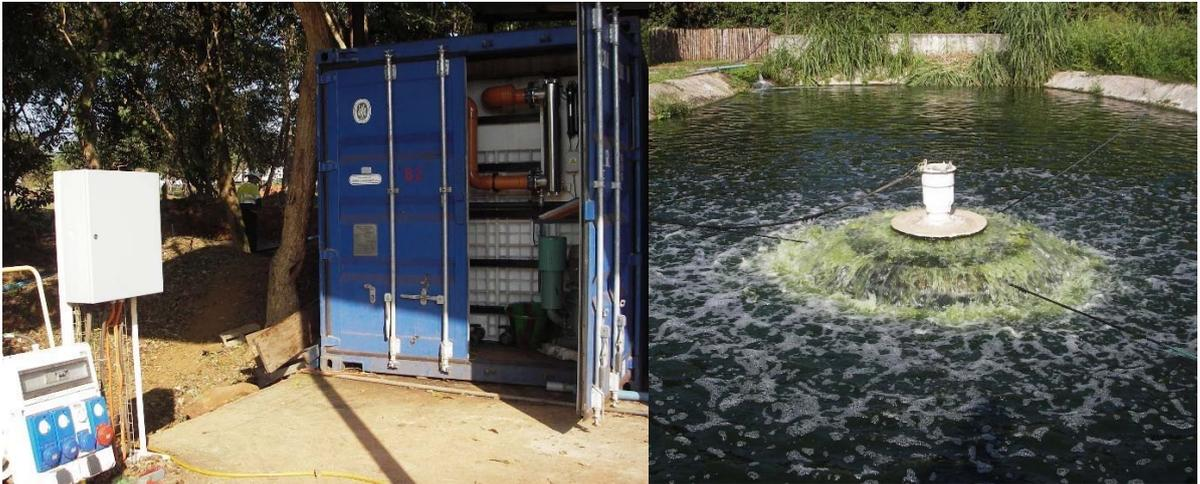
Figure 16. BioKube et aérateur aux lagunes pour le traitement des eaux usées (Cité 1)
