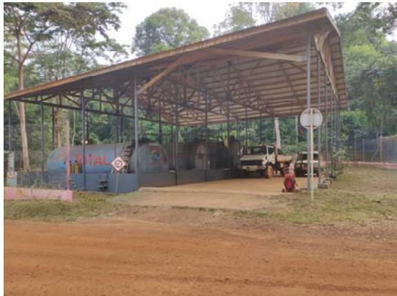
Figure 17 : Extension de la toiture du hangar de la station à Charlie 4
