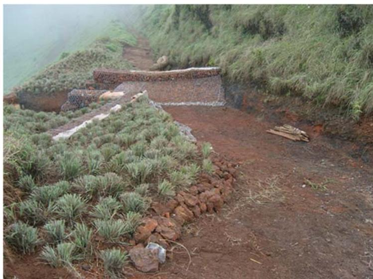
Figure 12 : Berme de structure Gabion Reno réhabilité, avec transplantation d'herbes
